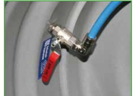
wird ein Kugelhahn montiert, der jeweils nach dem Abstellen des Fahrzeugs von Hand geschlossen werden muß.
